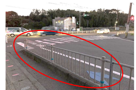
設置されたガードパイプ(防護柵)
